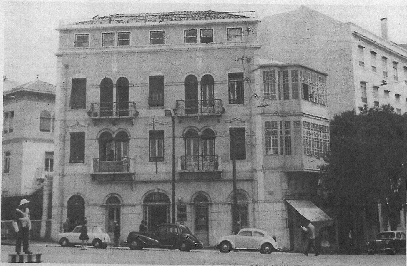
O edifício como estava ao tempo da CEI e que os interesses imobiliários não permitiram que se guardasse como instituição e local de referência
